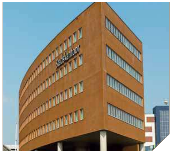
Gesloten gevel met openingen.
